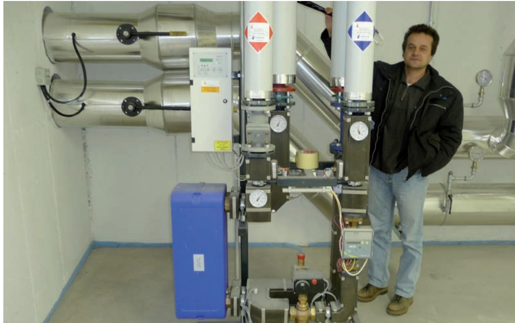
Manutenzione: Thomas Volgger, addetto al servizio clienti e alla manutenzione dell'impianto di teleriscaldamento
