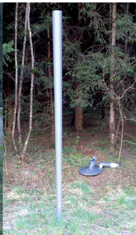
Lampade fotovoltaiche distrutte a Caminata
